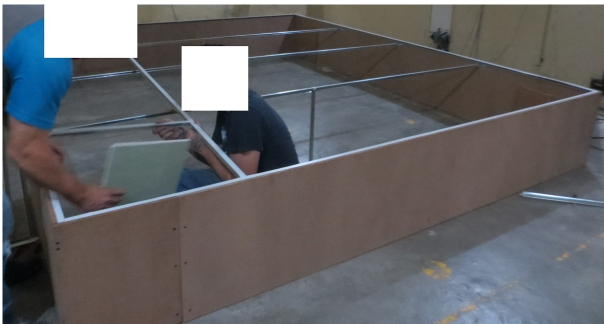
Figura 2.4 – Montagem da estrutura.
